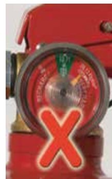
รูปที่ 3 เข็มอยู่ที่ช่องพื้นที่ "สีแดงขวามือ" แสดงว่า "เครื่องดับเพลิงอยู่ในสภาพชำรุดรุนแรงเกินกว่าที่กำหนด" ไม่พร้อมใช้งานและอันตราย
